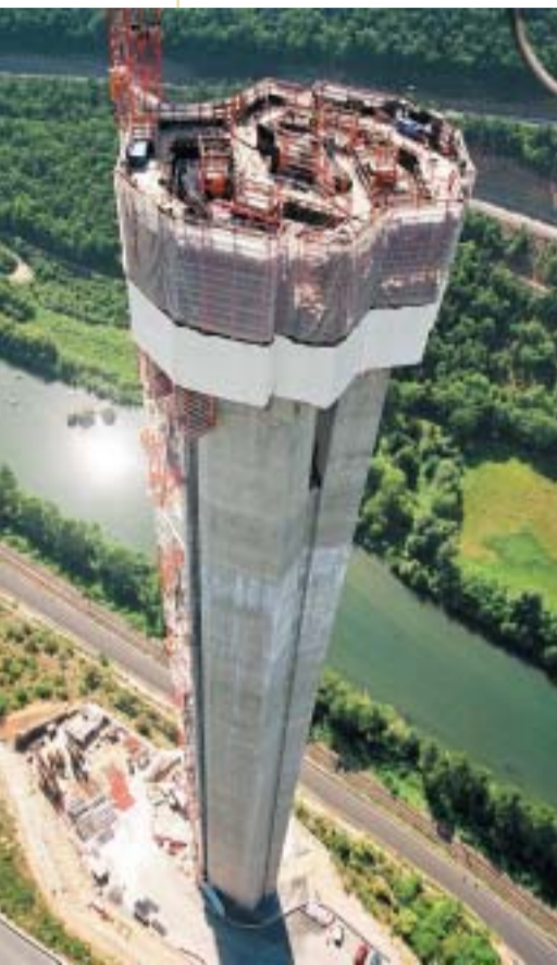
Pile P2 : près de 200 m et ce n'est pas fini !
