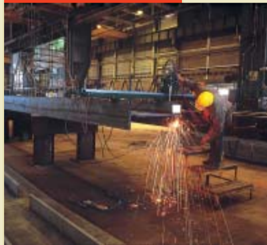
Travail d'orfèvre pour l'assemblage des caissons.
